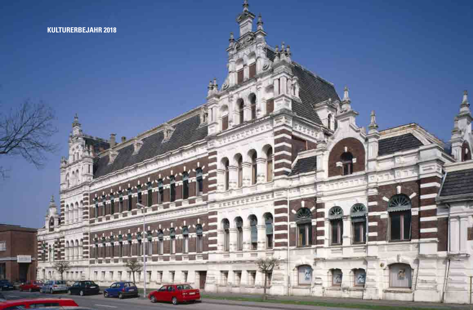
Fabrikgebäude Van Delden, ehemaliges Verwaltungsgebäude der Gebrüder Laurenz Textilwerke, Neo-Renaissance, Ochtrup (Kreis Steinfurt)
